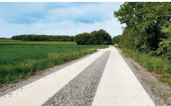
Feldweg nach dem Ausbau
